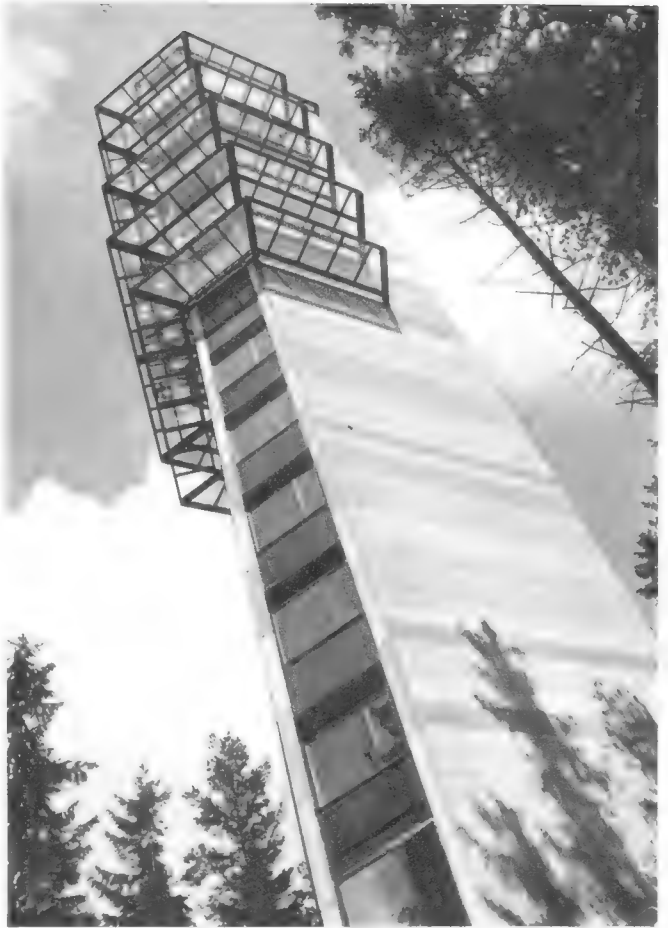
Bild 4. Ein wichtiger Knotenpunkt des Richtfunknetzes in der Schweiz auch für die Eurovision: Fernmeldeturm auf dem Felsenegg/Albis
